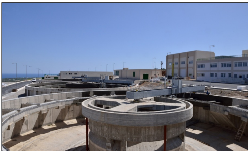
Εικόνα 2: Η Εγκατάσταση Επεξεργασίας Νερού του Αποσελέμη
