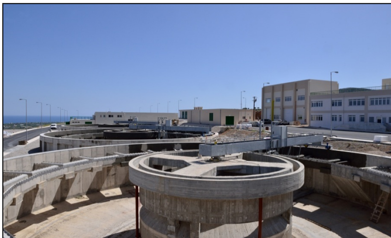
Εικόνα 2: Η Εγκατάσταση Επεξεργασίας Νερού του Αποσελέμη
