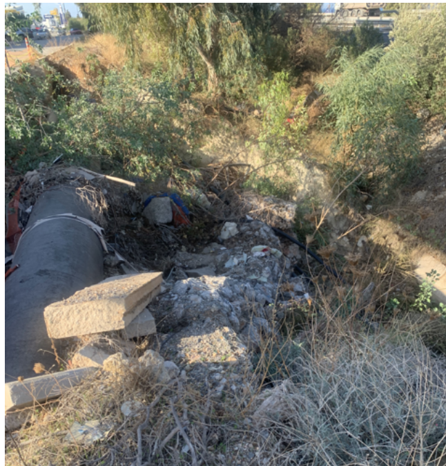
Εικόνα 2.: Περιοχή διέλευσης αγωγού ύδρευσης φράγματος Αποσελέμη στη ΒΙ.ΠΕ. Ηρακλείου.
