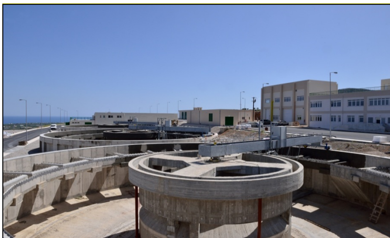
Εικόνα 2: Η Εγκατάσταση Επεξεργασίας Νερού του Αποσελέμη
